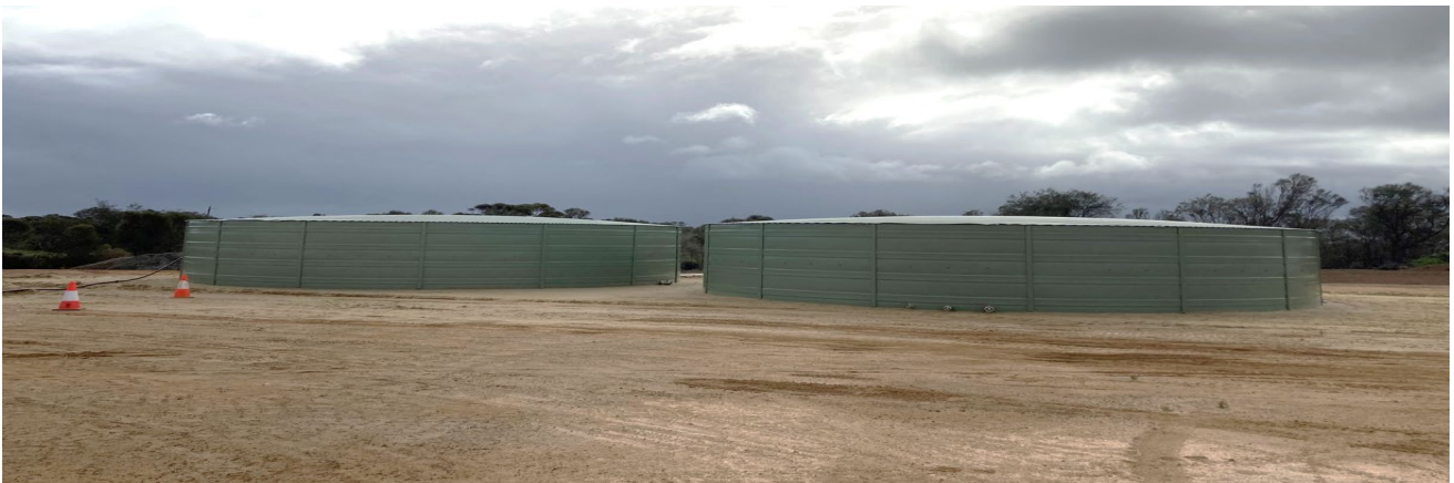
2 x 250 kL tanks
